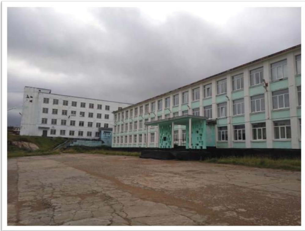
Капитальный ремонт участка площади перед зданием № 2 по ул. Бессонова до ремонта
