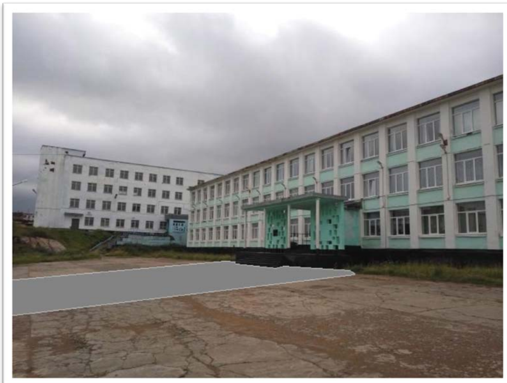
Капитальный ремонт участка площади перед зданием № 2 по ул. Бессонова после ремонта
