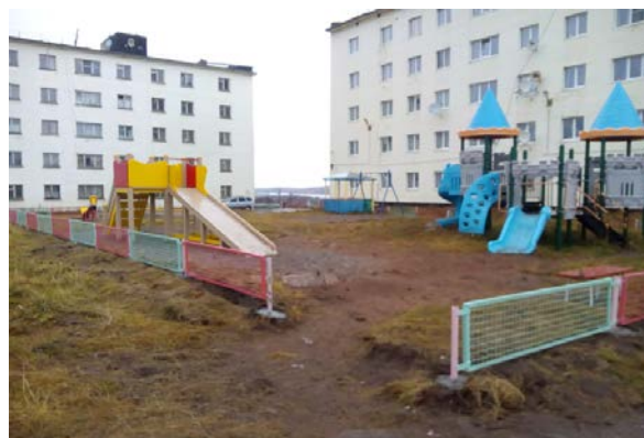
Капитальный ремонт детской площадки дома № 3 по ул. Жертв Интервенции
